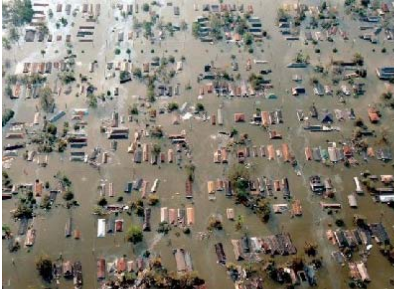
Construções inadequadas para regiões sujeitas a alagamento.
