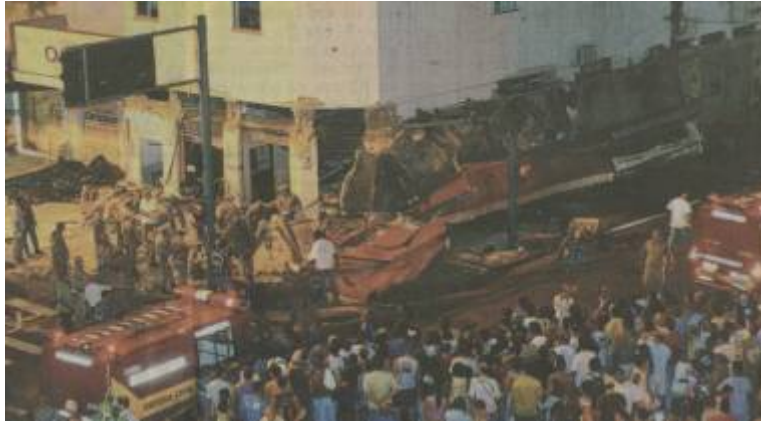
Desabamento de marquise em 24/03/06 – Vila Isabel
