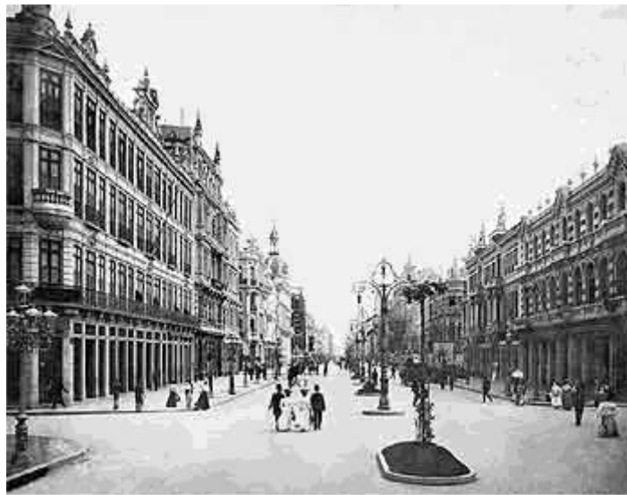
Av. Rio Branco – início do século passado. Padrão típico de construções de até 4 pavimentos com estrutura auto-portante.
