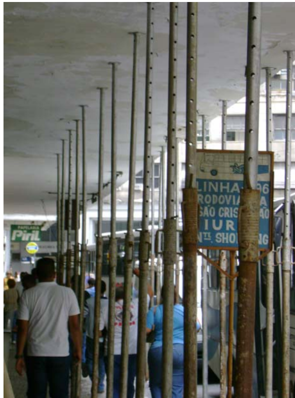
Exemplo de escoramento dimensionado e instalado corretamente.
